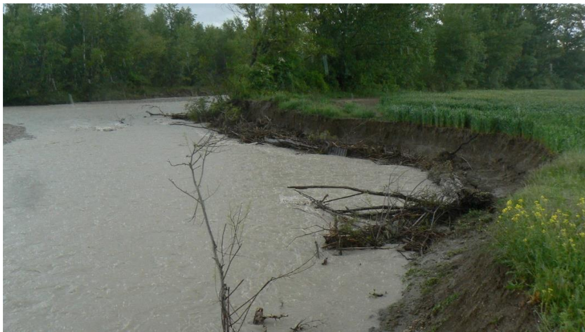
Figure 3: Erosion de la berge avec perte de parcelle agricole (Ribiers, mai 2013)
